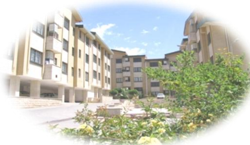
مجمع مسکونی مریم پردیس ▲
