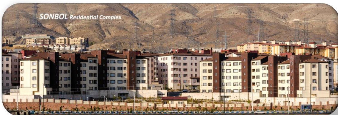
مجمع مسکونی سنبل پردیس ▲
