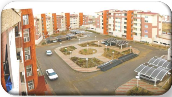
مجمع مسکونی زنبق پردیس ▲
